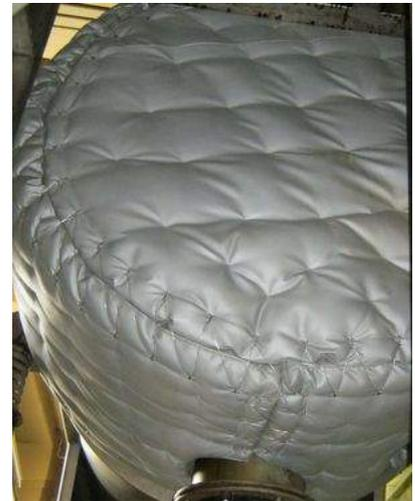
Darüberhinaus wird durch den Einsatz hochwertiger Materialien für die Dämm-Kissen, vorwiegend der Brandklasse A1 ein sehr guter Brandschutz und weiterhin eine lange Lebensdauer der Dämm-Kissen gewährleistet.
